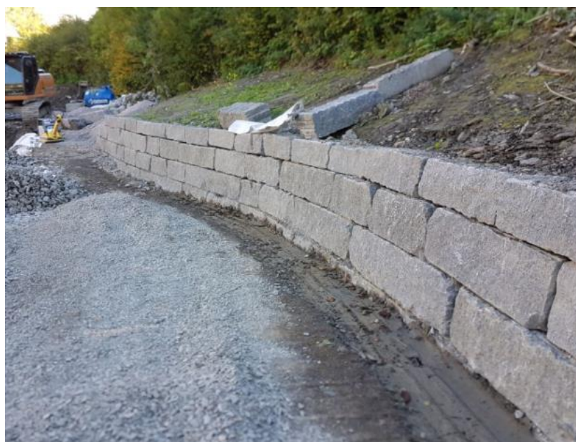
Figur 8 Larvik blokk rustikk med borede fuger - eksempel på ønsket steintype for ny støttemur.
