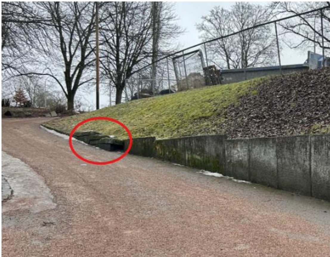
Figur 6 Eksisterende natursteinsblokker som skal demonteres og mellomlagres for fremtidig gjenbruk
